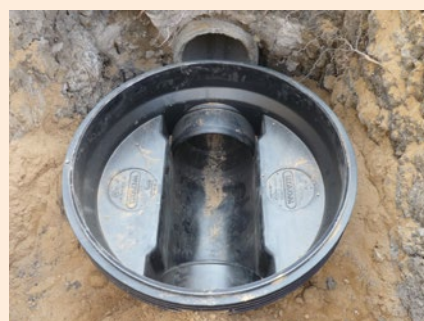
Sanace kanalizačního potrubí DN 300 a DN 400 v Praze Běchovicích probíhala současně s výměnou kanalizačních šachet
