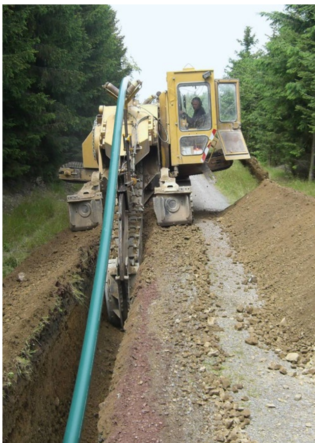
Pokládka kanalizačního potrubí SafeTech RC d140mm a Wavin TS d140 frézováním v Friedrichsbrunn Harz a Strassberg Harz
